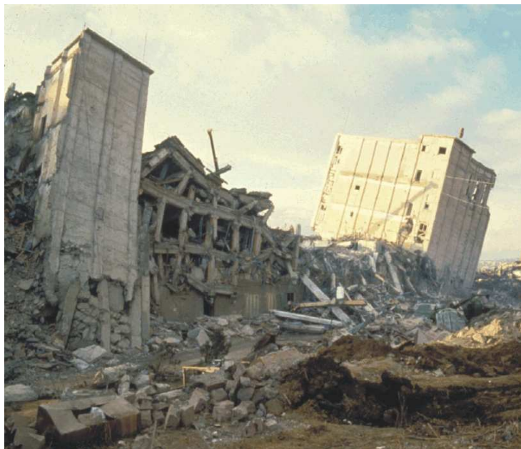
Fig.1.1 – Exemplo dos efeitos devastadores da acção sísmica na estrutura de um edifício
